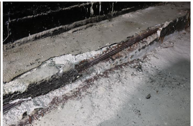
9 pav. Blogas kontaktas tarp perdangos bloko ir vielapluoščių apsauginio betono sluoksnio.
