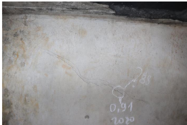
6 pav. Plyšiai perdangos blokuose
