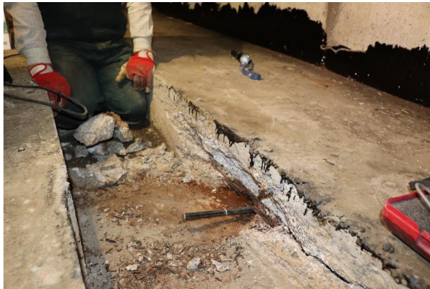
9 pav. Blogas kontaktas tarp perdangos bloko ir vielapluoščių apsauginio betono sluoksnio.
