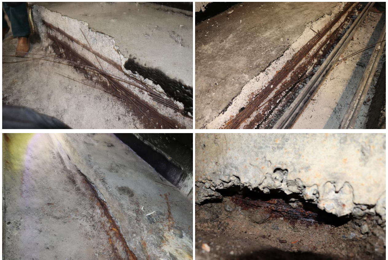
7 pav. Iš anksto įtemptųjų vielapluoščių pažaidos
