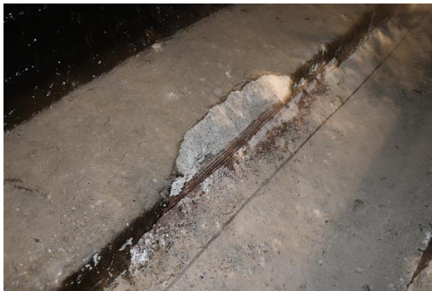
9 pav. Blogas kontaktas tarp perdangos bloko ir vielapluoščių apsauginio betono sluoksnio.
