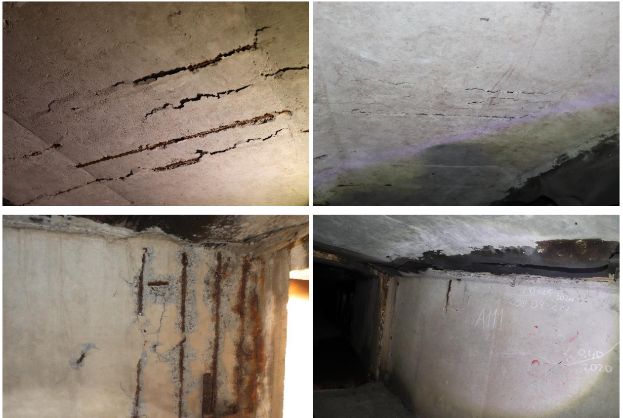
15 pav. Per mažas apsauginis sluoksnis paklotą laikinčioje plokštėje (viršuje) ir blokų sienutėse (apačioje) bei prasidėjusi armatūros korozija
