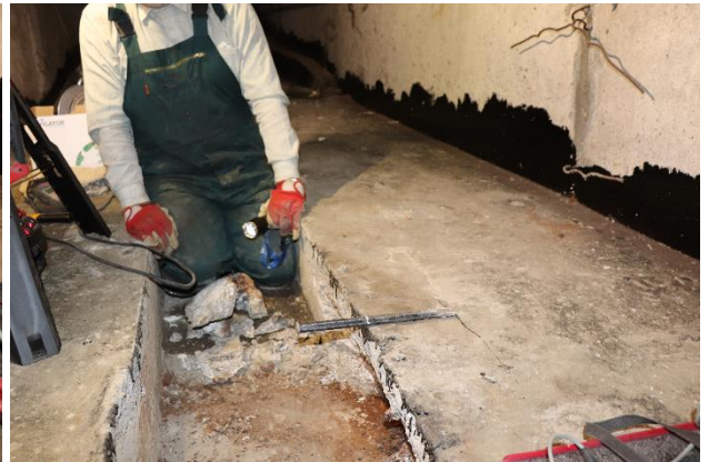
9 pav. Blogas kontaktas tarp perdangos bloko ir vielapluoščių apsauginio betono sluoksnio.
