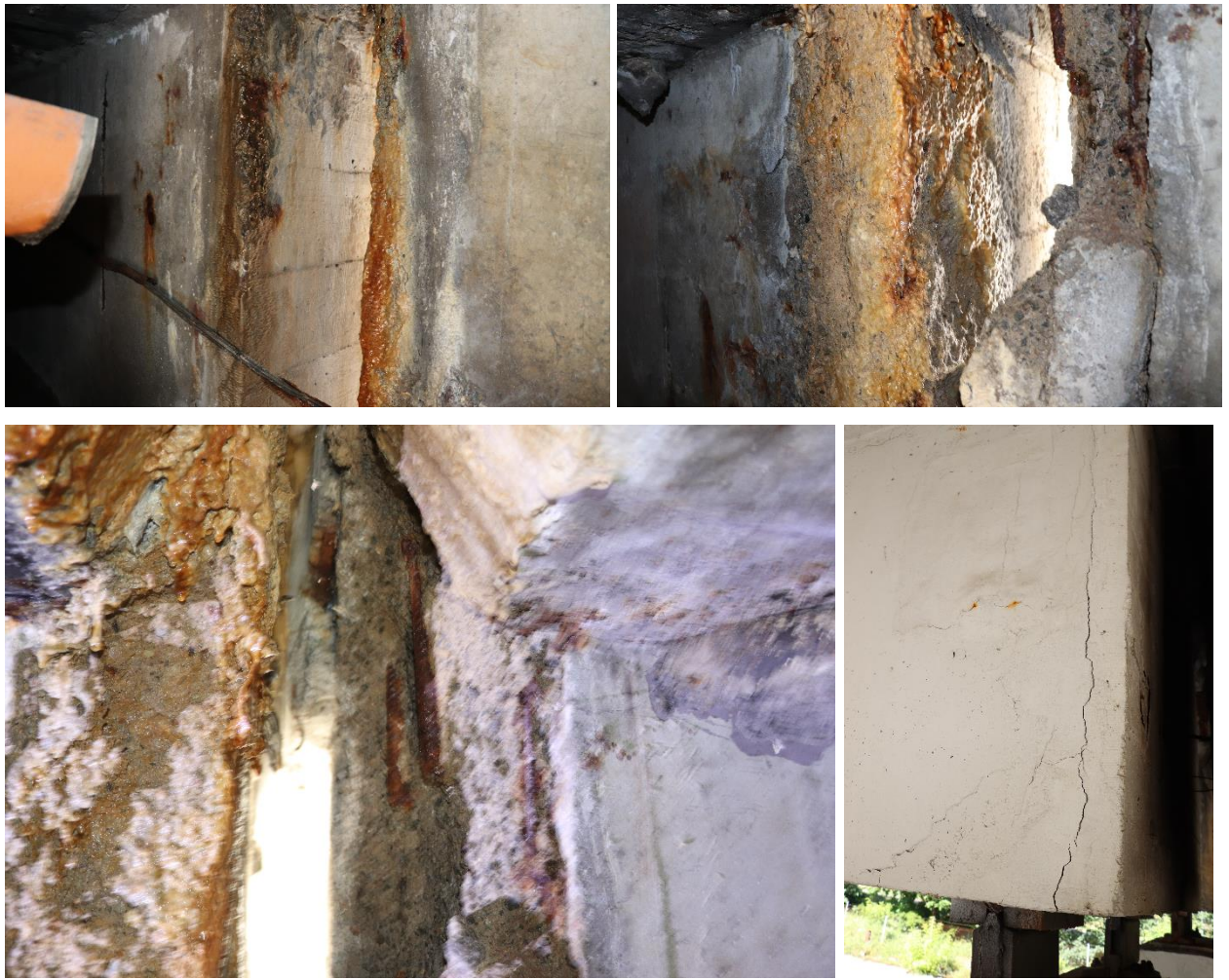
16 pav. Nesandarių deformacinių pjūvių sukelti sijų atraminių zonų pažeidimai
