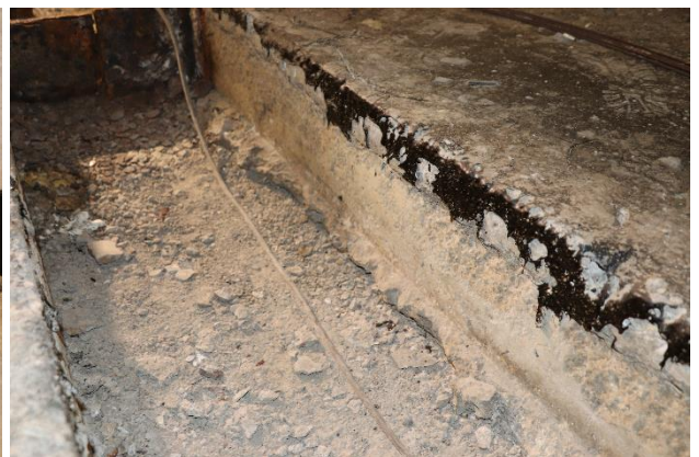
10 pav. Vielapluoščių apsauginio betono sluoksnio defektai: atšokęs sluoksnis (viršuje), atskilęs sluoksnis (apačioje kairėje), nekokybiškai įrengtas sluoksnis (apačioje dešinėje)
