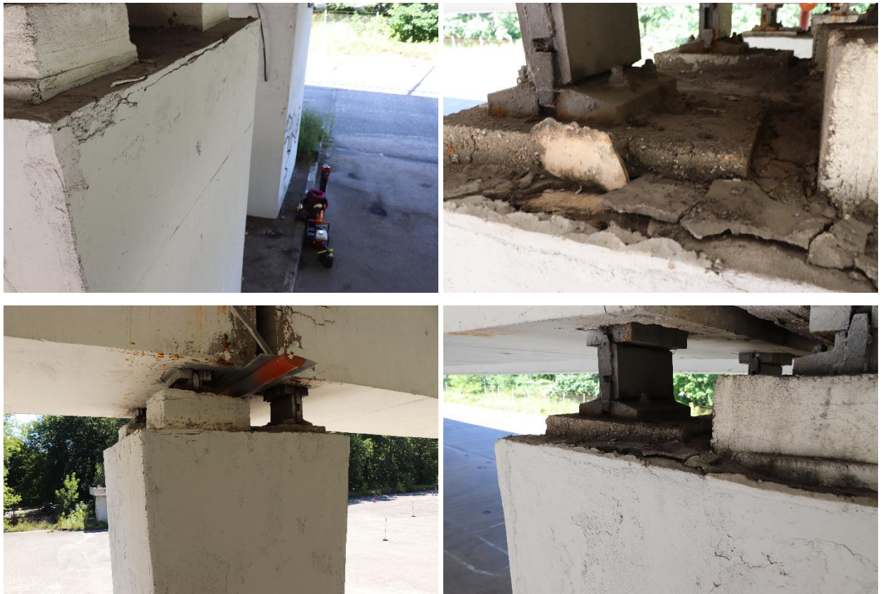
18 pav. Tarpinių atramų 4–6 viršutinių zonų defektai
